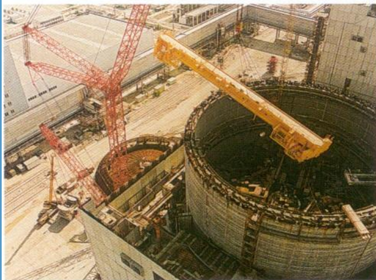
Montáž vrchlíku kontejneru
